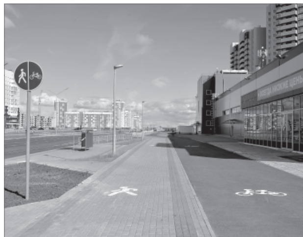
Новый участок магистрали на улице Ленина оснащен велосипедными дорожками, тротуарами и освещением.
