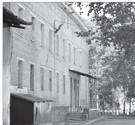
Досрочно выполнен капитальный ремонт кровли детского сада. Старейшему в городе зданию теперь не грозит ни дождь, ни промерзание стен.
