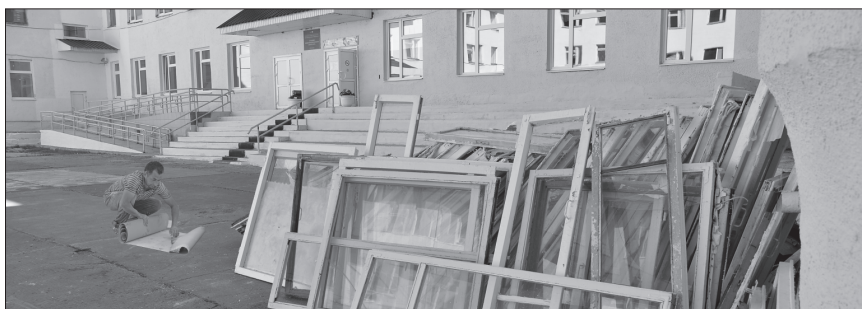
До конца лета завершатся работы по установке 273 оконных блоков.
