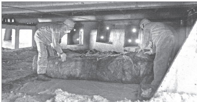
Работники жилищного треста №1 уверены: минеральная вата способна сохранить тепло в условиях суровой зимы и обеспечить прохладу знойным летом.
