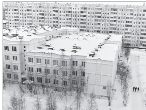
На фото Михаила Плецкого: световые фонари стеклянной части крыши школы №40 обновят с приходом лета.
