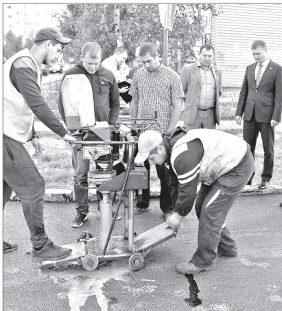
Общественники принимают участие в приёмке дорог, следят за ходом капитального ремонта домов.
