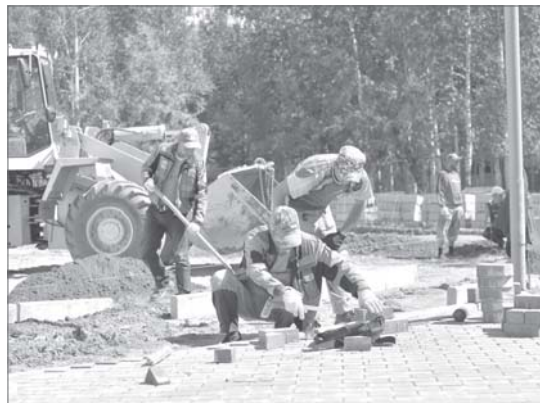
Бульвар Рябиновый по всей длине будет выложен тротуарной плиткой двух цветов: терракотовый и серый.
