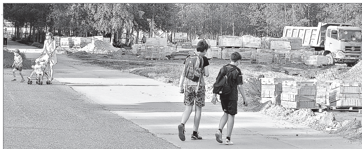
В пятом микрорайоне активно продолжаются работы по реконструкции Космопольского бульвара.
