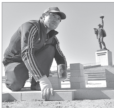
Андроник Гаспарян на укладке бордюрного камня у подножия памятника «Покорителям Самотлора». На данный момент работы идут полным ходом.
