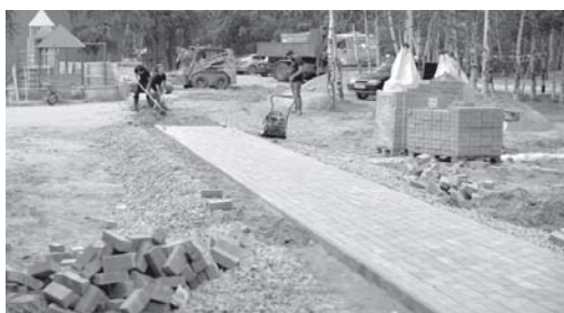
Идут работы и по прокладке тротуаров во 2-м микрорайоне.
