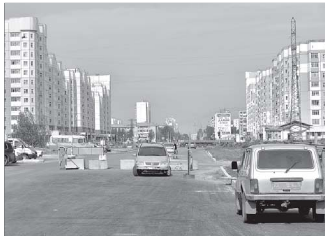
Строится дорога на границе между 24 и 25 микрорайонами.
