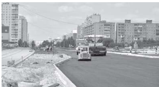
Заканчиваются работы по улице Ленина в новостройках.
