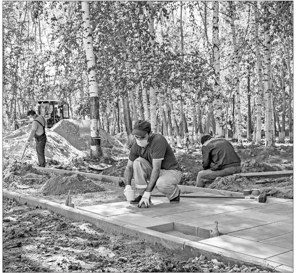
В будущем сквере Героев Самотлора кипит работа.
