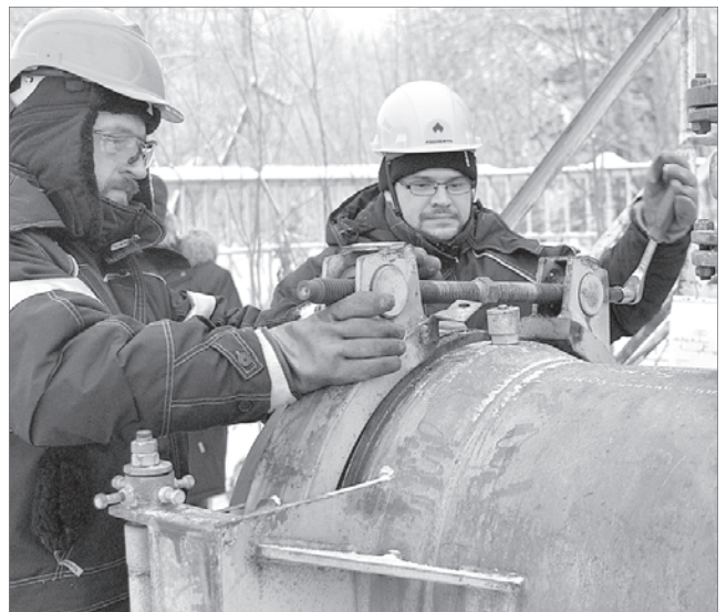
Специалисты подготавливают камеру пуска для ввода снаряда в трубопровод.
