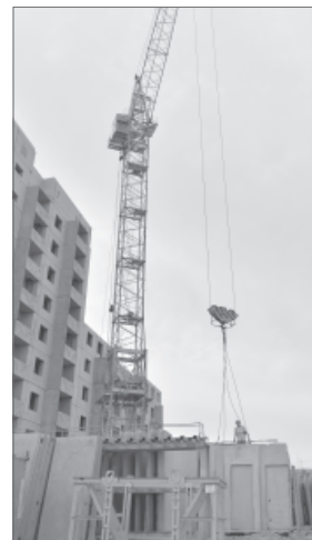
Строительство доходного дома идёт хорошими темпами.
