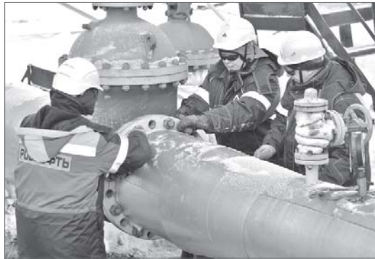
Идет демонтаж задвижки.
