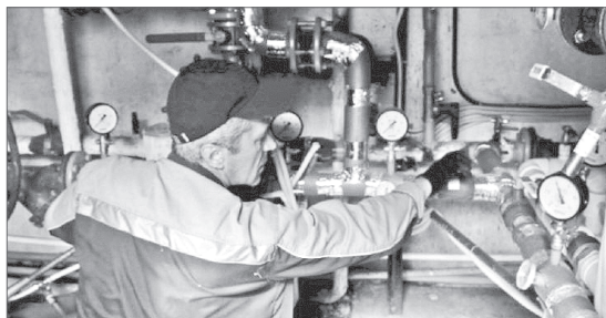
Слесарь Михаил Сысоев внимательно следит за процессом гидроневматической промывки труб.
