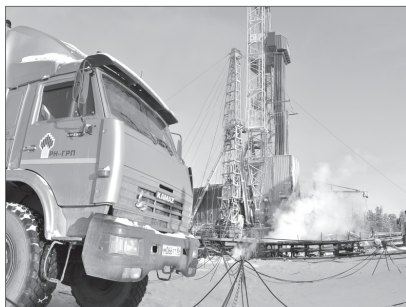
Подготовка к ГРП.
