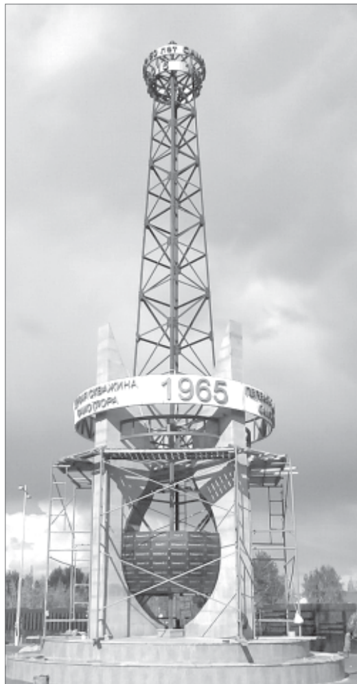
Заканчивается строительство нового мемориального комплекса на первой скважине Самотлора Р-1.
