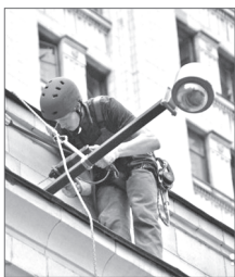
Установка видеонаблюдения во дворах.
