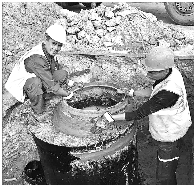
Гидроизоляция колодцев идёт полным ходом.
