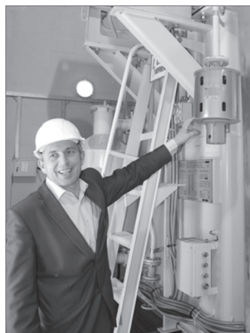
Новое оснащение подстанции.
